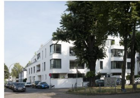
135 Wohnen an der Nidegger Straße in Köln
